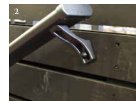
Pour les mains courantes seules 1. Fixation murale simple 2. Pose sur écuyer pour main courante
