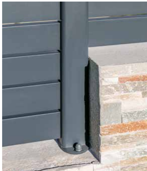
^ Poteaux avec redans sur platines 2 points.
