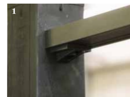
Pour les mains courantes seules 1. Fixation murale simple 2. Pose sur écuyer pour main courante
